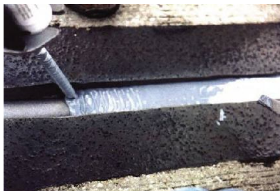
درزگیری با ماستیک درزگیر (درزگیر سرد سیلیکونی)
