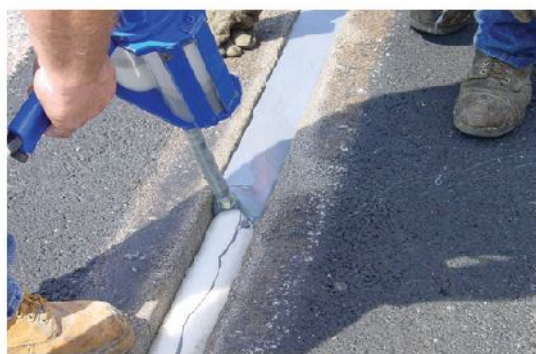
درزگیری با ماستیک درزگیر (درزگیر سرد سیلیکونی)
