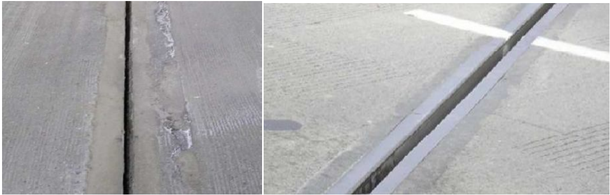
درز تمیز و آماده برای نصب اسفنج و ماده درزگیر
