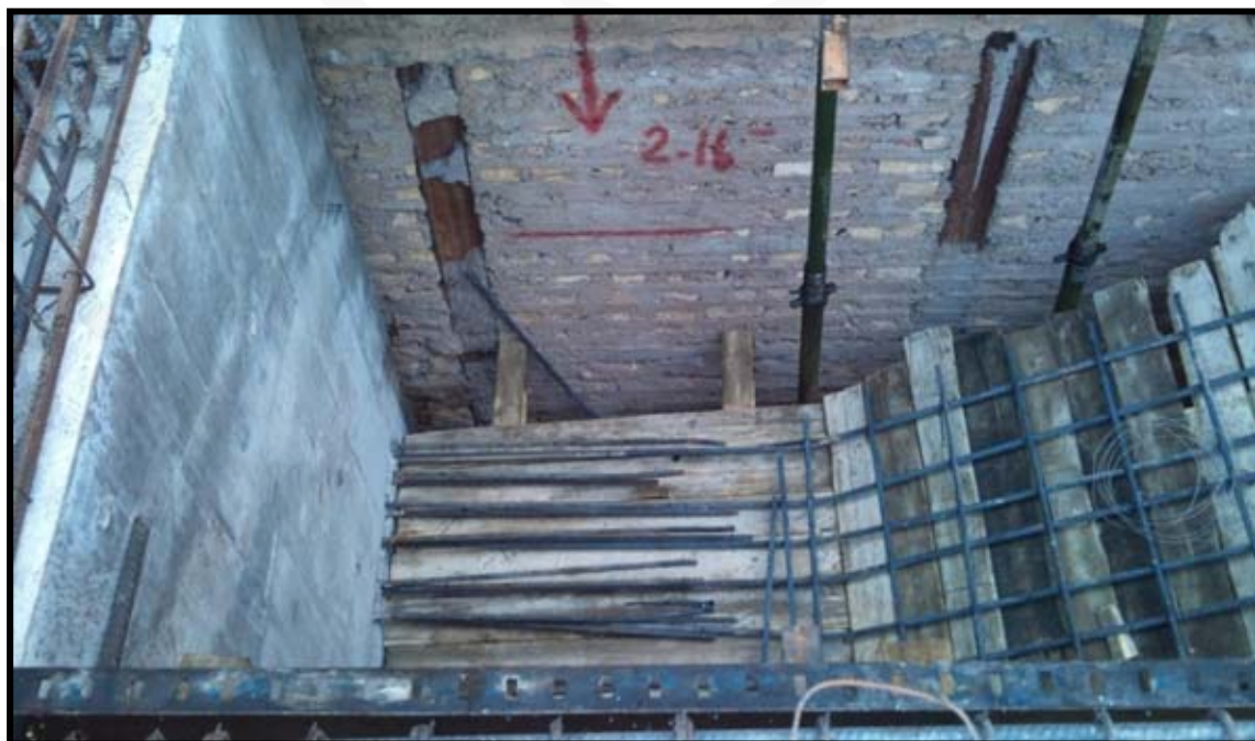
شکل زیر آرماتورهای انتظار پاگرد پله در دل دیوار برشی را نمایش می دهد.
