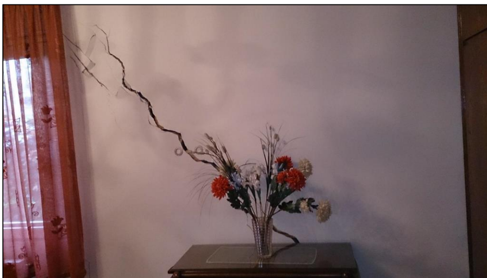
شکل ۱: ترک ایجاد شده در دیوار در اثر گودبرداری ملک مجاور
