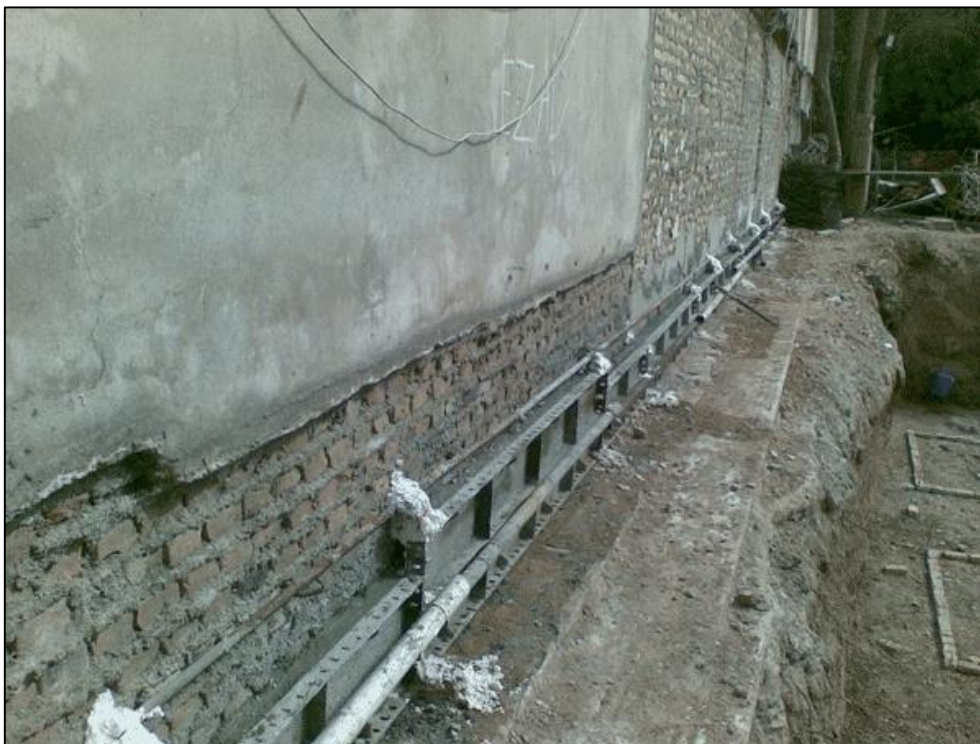
شکل ۶: گودبرداری بدون حفاظ و با استفاده از حاشیه خاکی (در این تصویر از یک نوار بتنی جهت حفظ یکپارچگی دیوار همسایه استفاده شده است)
