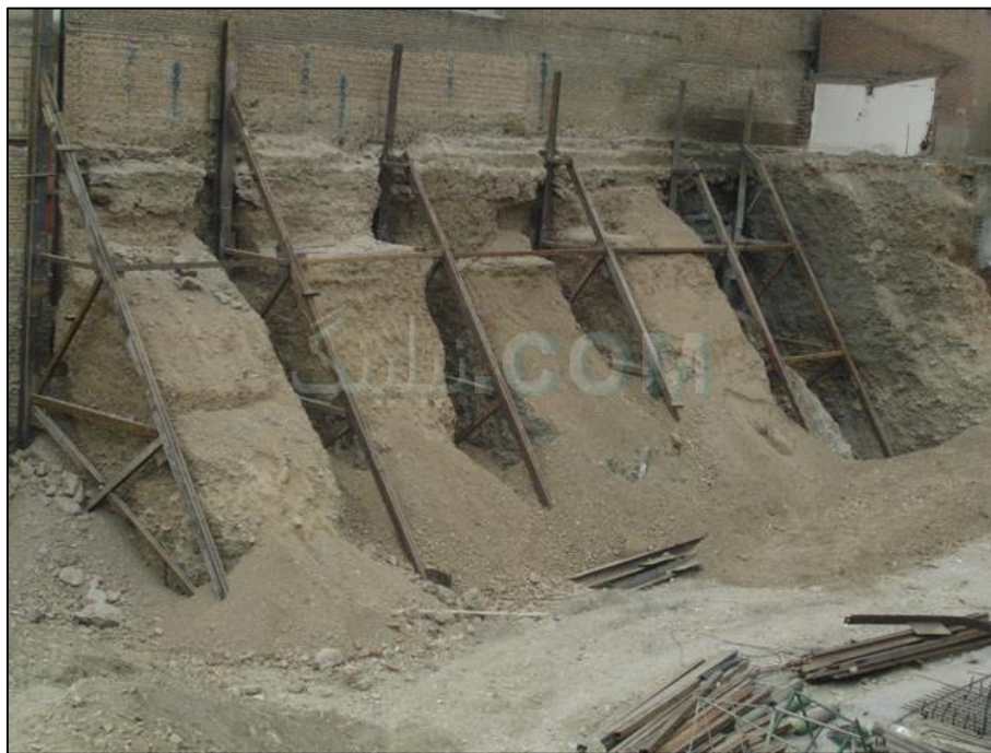
شکل ۱۲: اجرای اعضای قائم و مایل و نگهداشتن سپر خاکی
