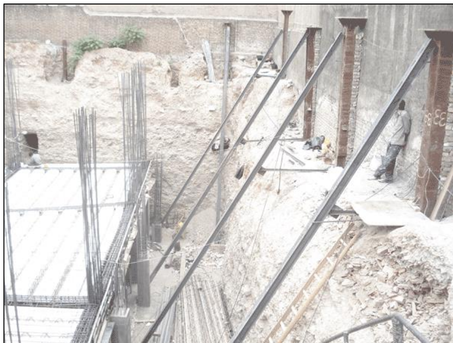
شکل ۷: حفظ حاشیه خاکی و نصب تیرک‌های قائم و مایل جهت حفظ گود
