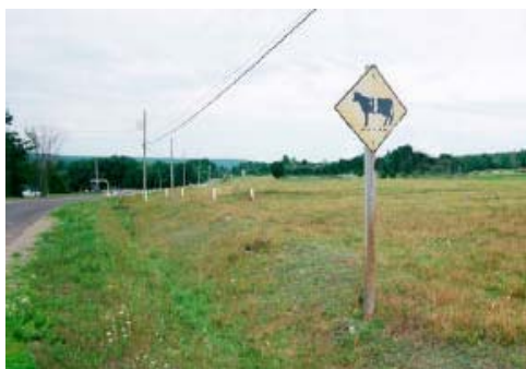
تصویر ۴- علائم کمرنگ و شکسته شده و با فاصله زیاد از راه
