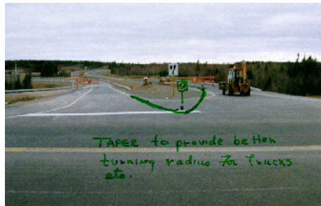
تصویر ۳- گرد بودن جداکننده رمپ‌های ورودی
