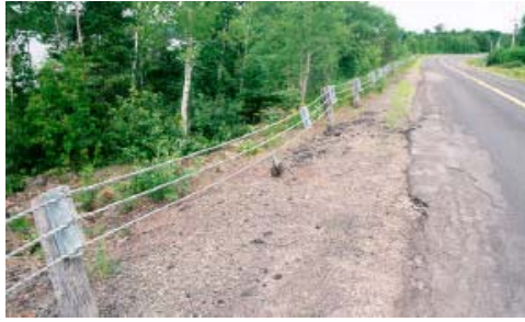
تصویر ۸- حفاظ فاقد پایه (پایه افتاده)
