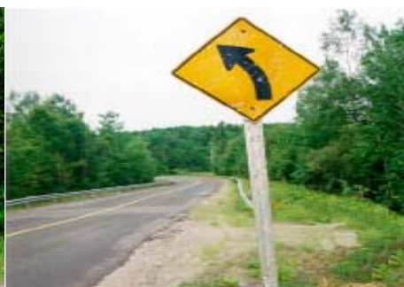
تصویر ۵- علامت شکسته شده و فاقد انعکاس مناسب
