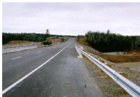
تصویر ۵- کاهش عرض خط باند غربی در انتهای غربی پروژه
