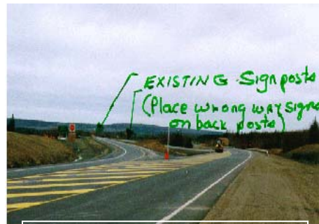
تصویر ۱- انتهای غربی پروژه که فاقد تابلوهای مورد نیاز است
