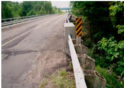
تصویر ۱۲- گاردریل با پایه انتهایی نرده پل همسطح نمی باشد.
